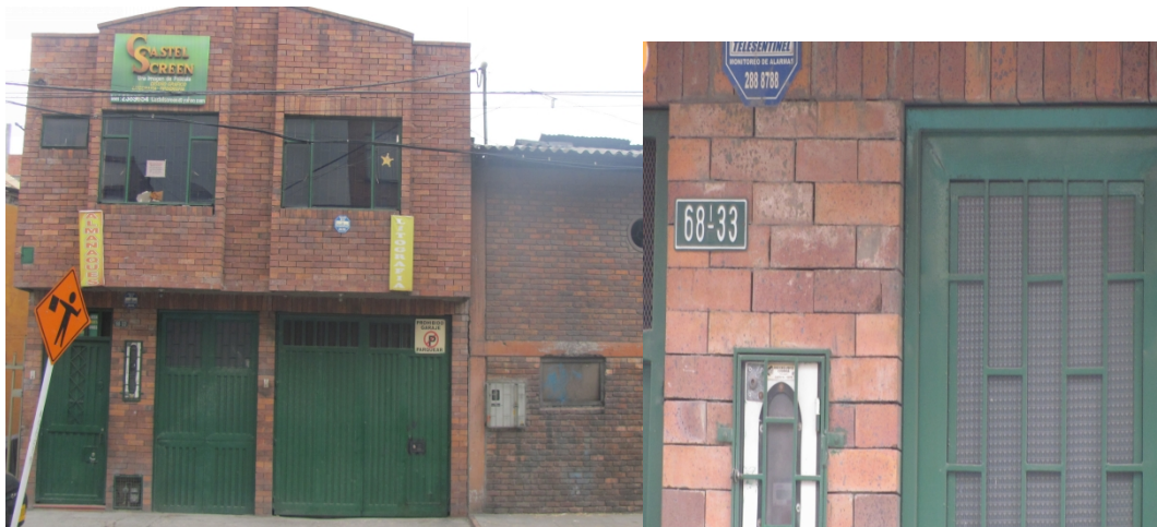
VISTA PANORÁMICA Y NOMENCLATURA DEL INMUEBLE – LA VALLA NO ESTÁ INSTALADA
